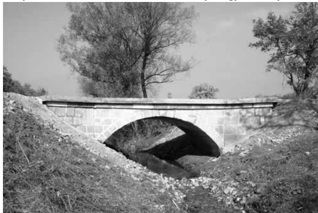
Befejezéshez közeledik a Füzesen átívelő Kutya-hegyi híd felújítása...
