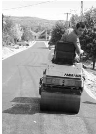
Az Ibolya utca felújítása
